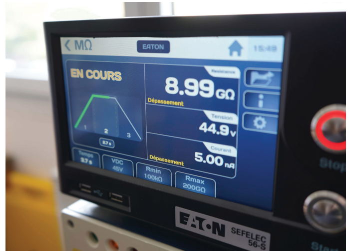
Isolationsmessung mit SEFELEC 56-S bei 45V
